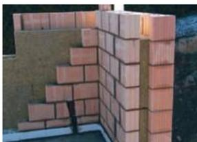
Isolation intermédiaire de la maçonnerie à double paroi:
