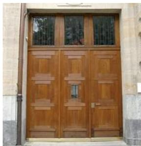
**1<sup>ère</sup> priorité:** Cadre et vantail en bois massif et isolation laine de pierre, cadre et vantail en bois massif et isolation laine de roche et vitrage partiel.
