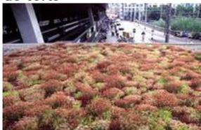
1<sup>ère</sup> priorité: Comparé au standard minimum selon la norme SIA 312, épaisseur de couche supérieure de 3 cm en moyenne, utilisation de plusieurs types de substrats, aménagements de petites structures (zones sablonneuses, reliefs, bois mort, etc.), semis avec un mélange de plantes indigènes favorisant la biodiversité.
