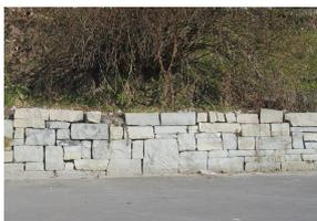
**1<sup>ère</sup> priorité:** mur en pierres sèches naturelles, éléments de talus en équerre 15 cm, éléments courbes de talus en béton (profondeur 40-50 cm).
