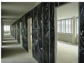
**1<sup>ère</sup> priorité:** Cloisons légères à montants simples ou doubles avec laine minérale et parement simple ou double en plaques de plâtre, plaques de plâtre à haute densité et plaques de plâtre acoustiques.
